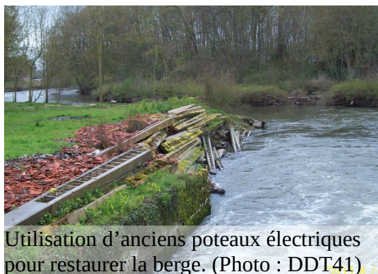
Utilisation de divers matériaux non solidaires sur une berge. (Photo : SEBB)
