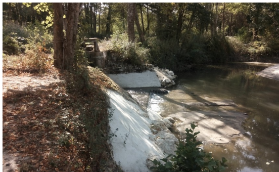
Utilisation de béton pour le renforcement de la berge. (Photo : DDT41)
