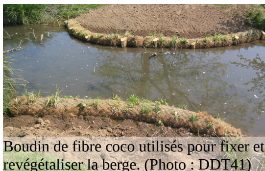
Restauration d'une berge au moyen de techniques douce de génie végétal. (Photo SEBB)
