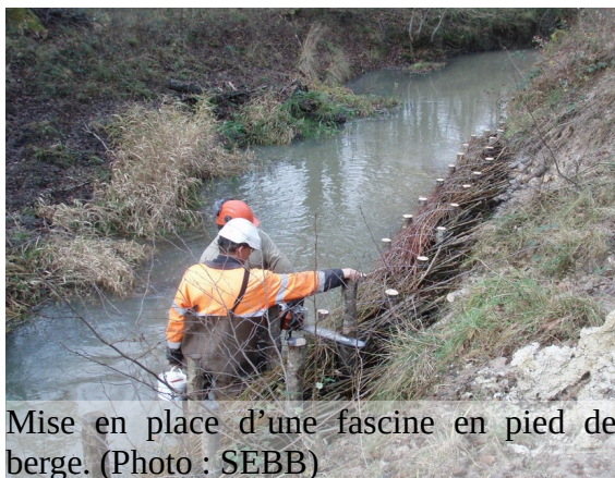
Restauration d'une berge au moyen de techniques douce de génie végétal. (Photo SEBB)
