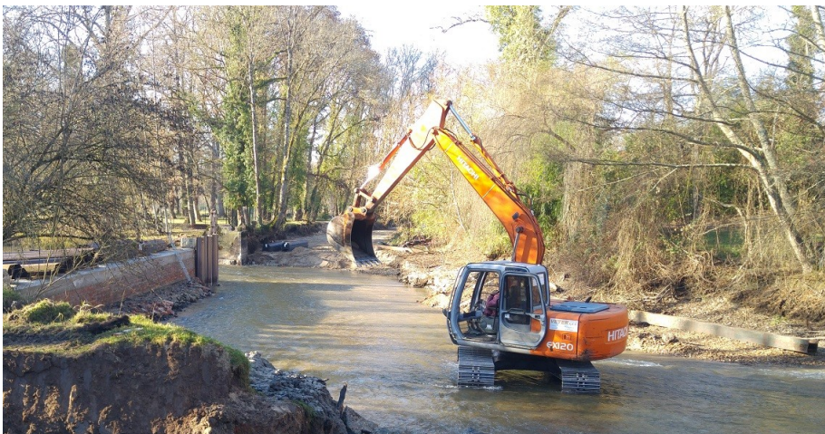
Intervention d'engin mécanique dans le cours d'eau. (Photo : DDT41)
