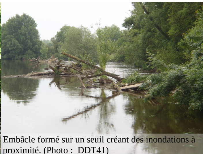
Chute d'arbres dans le cours d'eau pouvant former des embâcles en aval. (Photo : DDT41)
